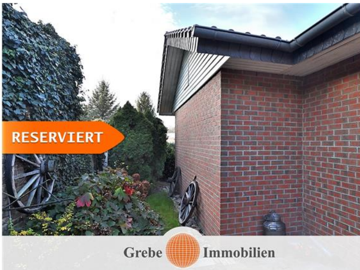
Blick hinter das Haus
